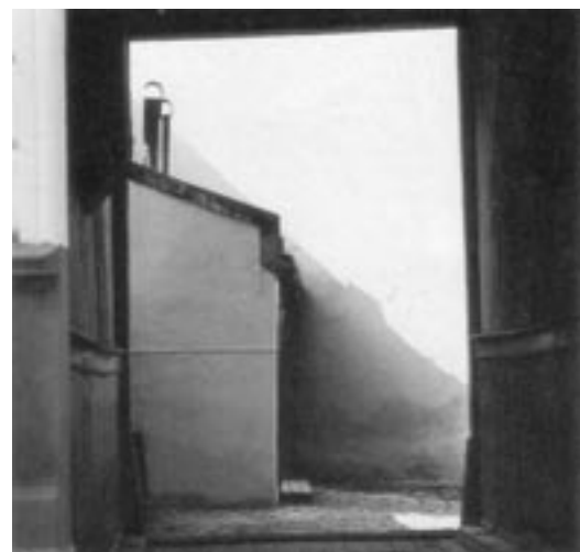
Portrom og utedoer med utlufting over tak.
